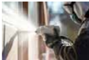
Sandstrahlen zur Lackentfernung
